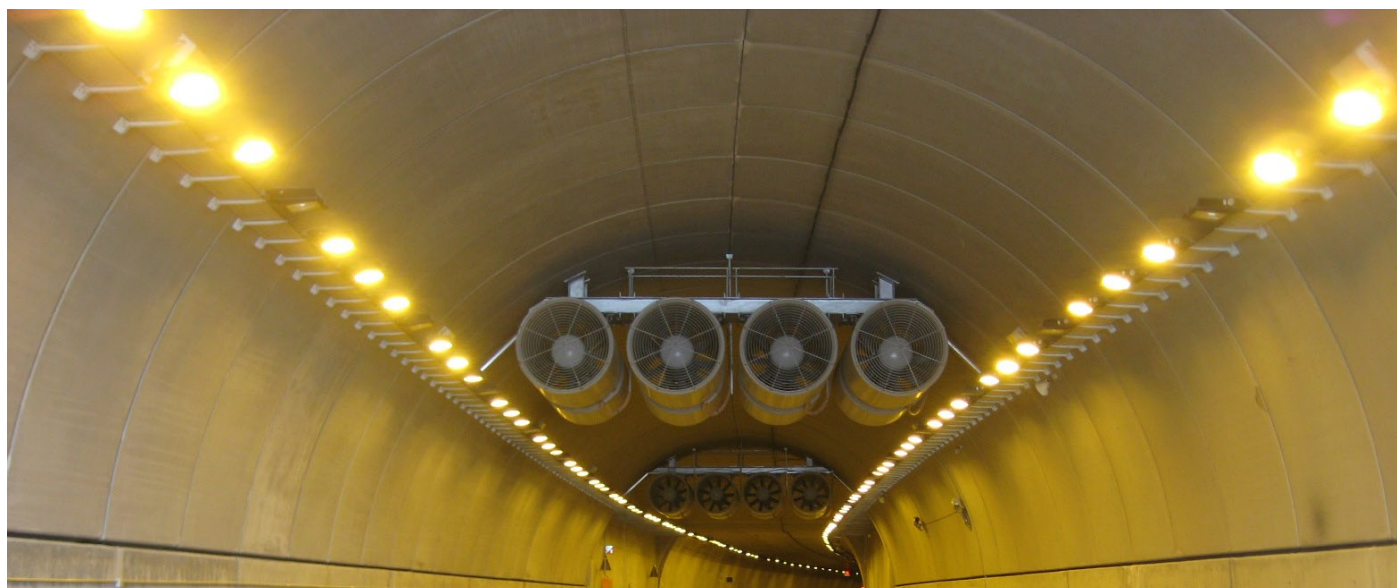
Túnel de Bracons
