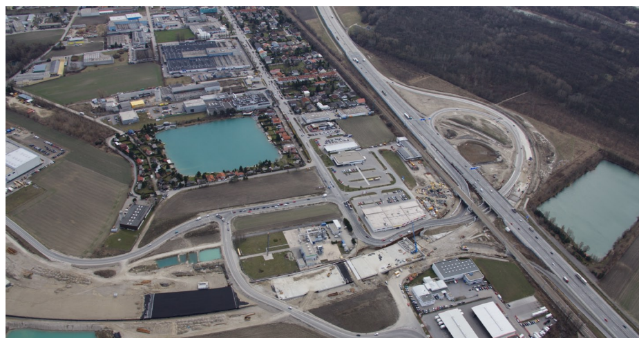
Vista aérea del túnel de Kreuzenstein
