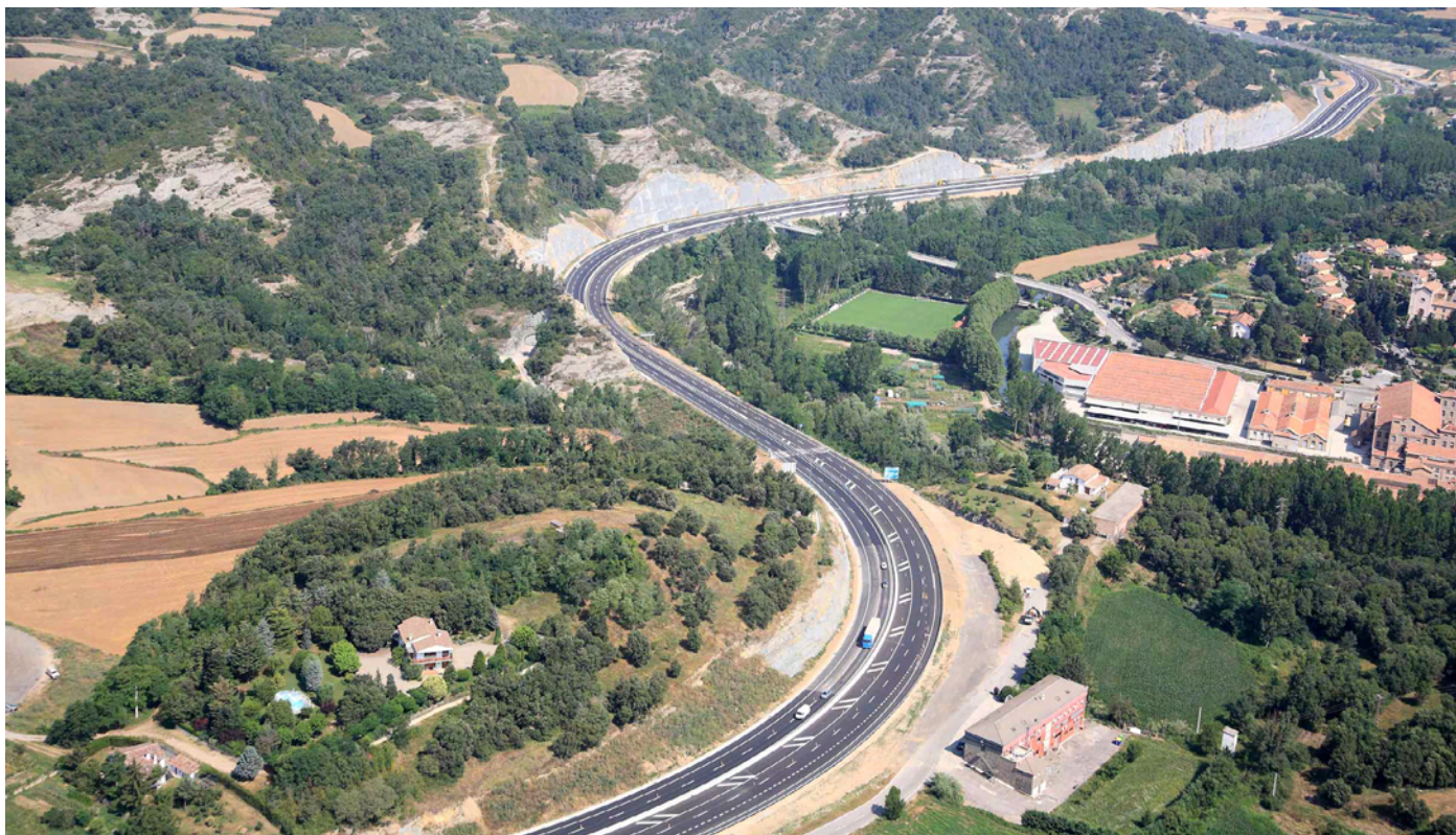
Vista área de un tramo de la C-17
