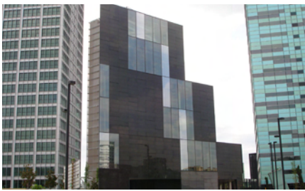
Fachadas de los edificios
